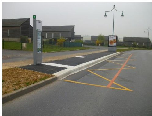
Arrêts de bus aménagés avec nez de quai contrasté et identification tactile de la porte avant du bus + guidage conducteur pour bon accès au quai du bus (ex. arrêt Redont à Champigny)
