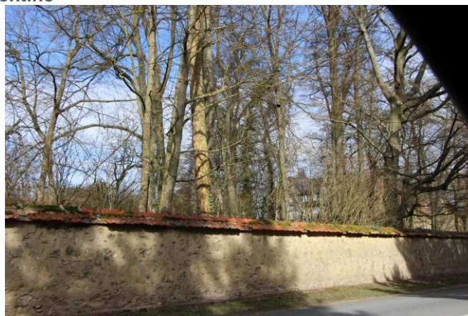
Mur d'enceinte de l'ancien château de Nouvion
