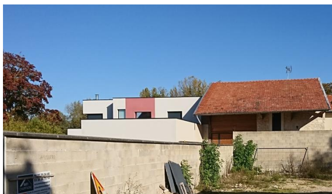
Exemple de renouvellement urbain et de diversité architecturale
