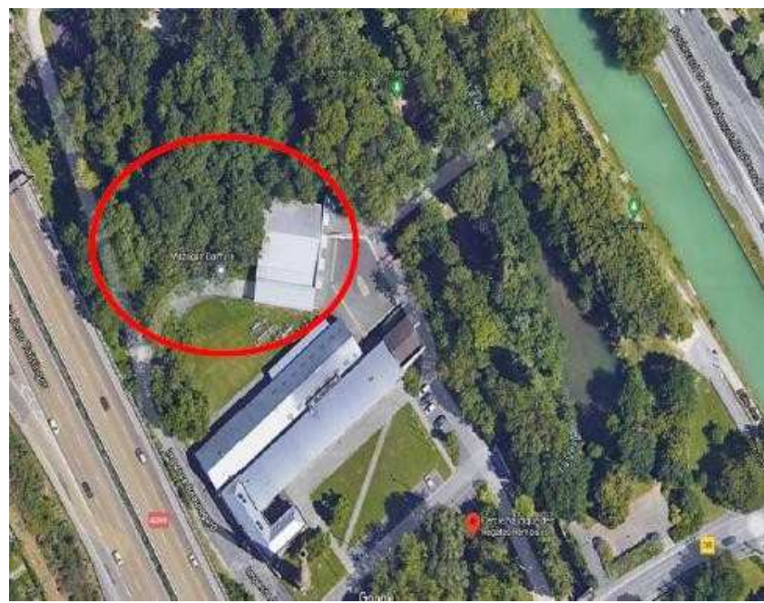
Localisation du site de projet sur la commune – zoom sur le site
