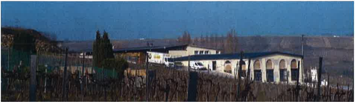
6 : Bâtiment viticole à la limite communale Ouest du village
