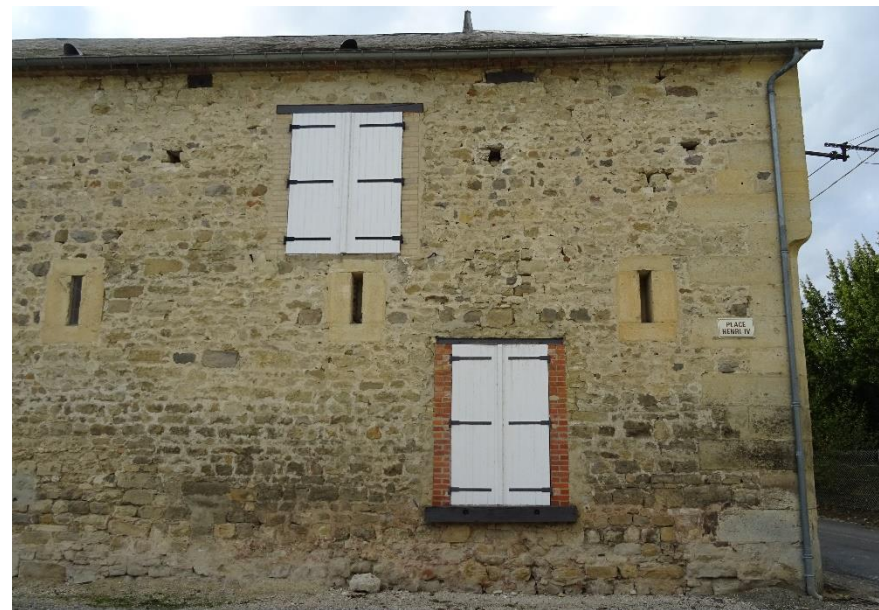
2, place Henri IV à Châlons-sur-Vesle - Façade en maçonnerie de moellons de pierre calcaire, encadrements de baie en pierre de taille ou en brique,
