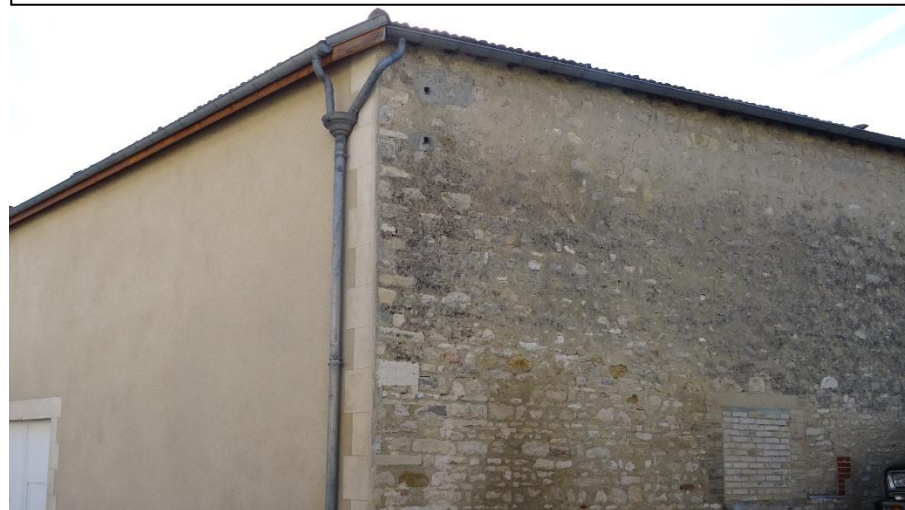
Façade enduite et pignon en maçonnerie de pierre rejointoyée
