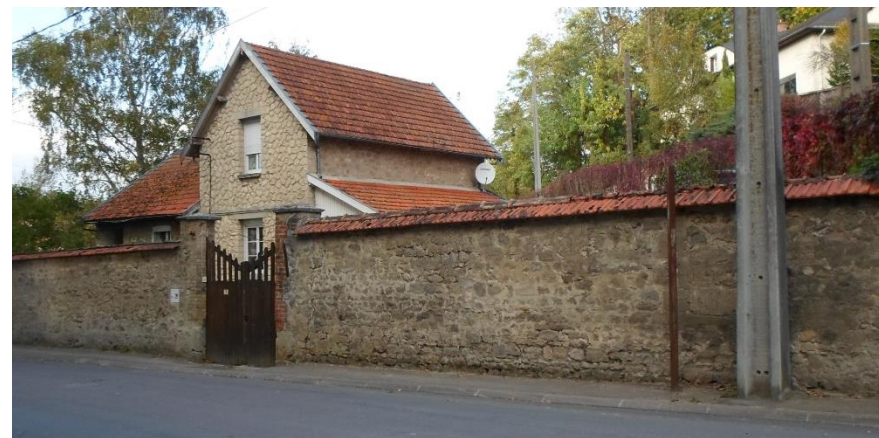
Couvertures en tuile, rue de Reims à Châlons-sur-Vesle -
