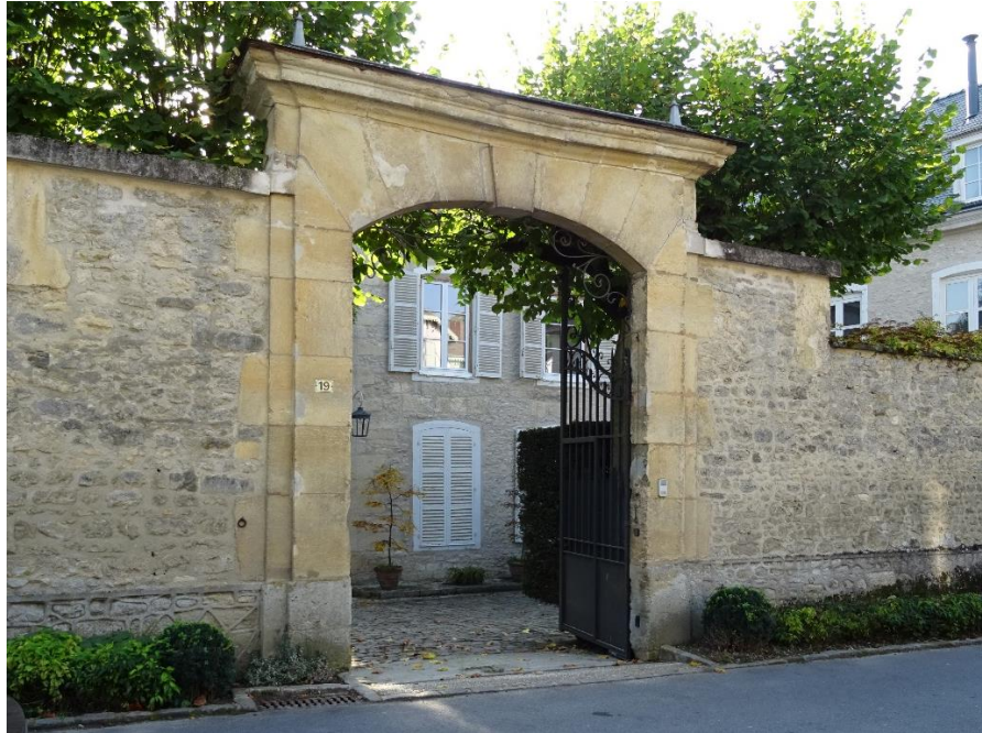
Portail en pierre de taille, calcaire jaune doré et mur de clôture en moellon de pierre calcaire, beige grisé et beige doré
