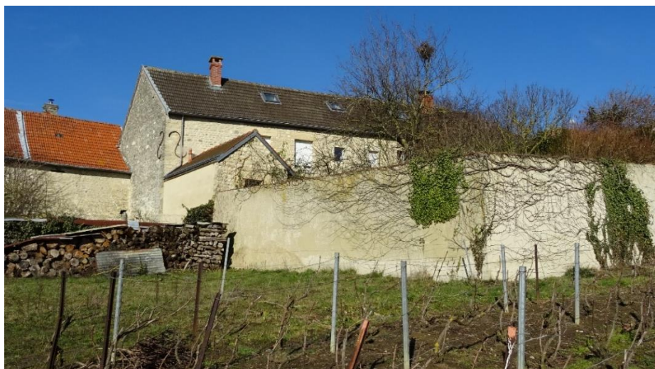
Murs de clôture en maçonnerie enduite s'harmonisant avec la teinte des mur en pierre .
