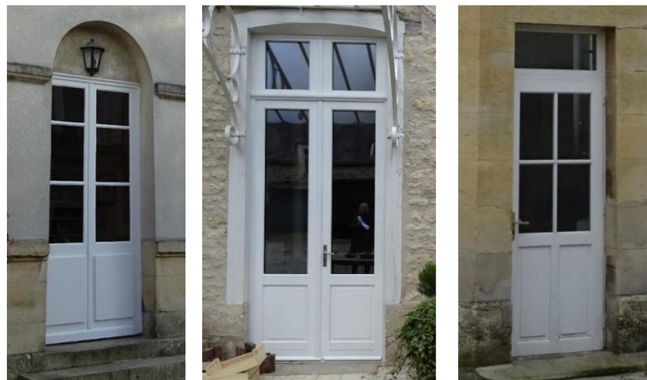
(4) Exemples de portes composées de panneaux moulurés et assemblés, la partie supérieure vitrée avec des petits bois
