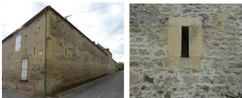
*Mur en maçonnerie de moellons de pierre et encadrement de baie en pierre de taille, de calcaire doré 2, Place Henri IV à Châlons-sur-Vesle*
