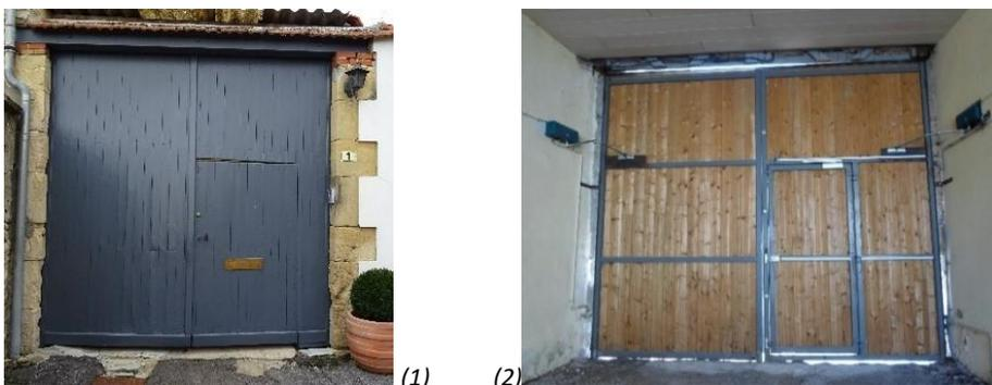
Exemple d'adaptation d'une porte charretière constituée de planches verticales sur une ossature métallique motorisée, (1) vue extérieure (2) vue intérieure.
