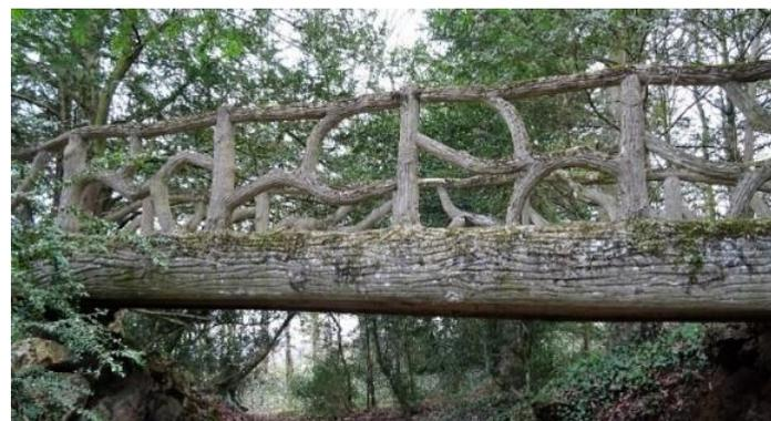
Garde-corps en béton moulé ferrillé, imitant les troncs d'arbres
