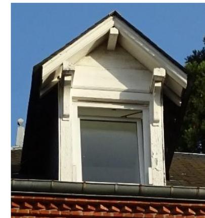
Exemples de lucarnes charpentées avec une toiture en bâtière
