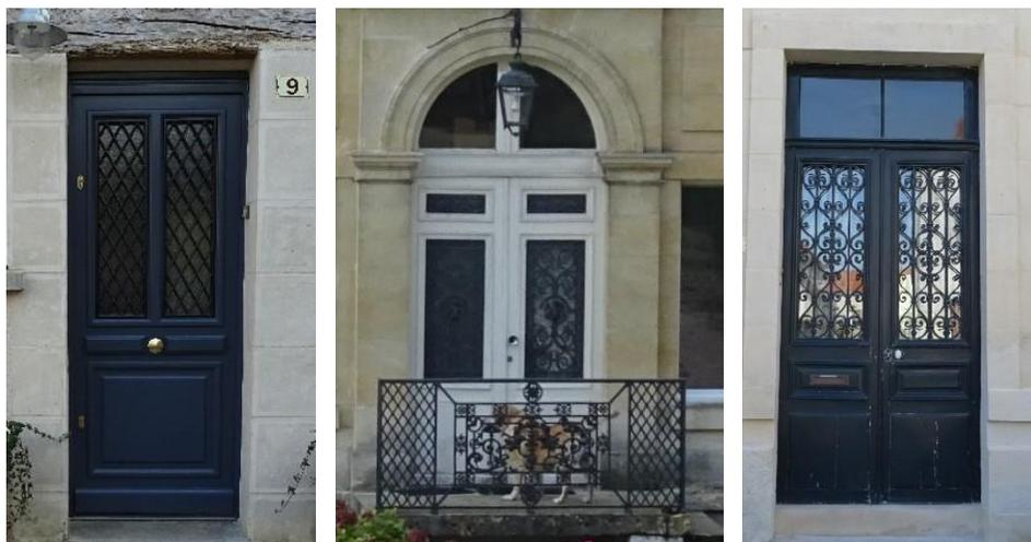
(3) Exemples de portes composées de panneaux moulurés et assemblés, la partie supérieure vitrée est protégée par des grilles en fer forgé ou en fonte moulée
