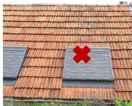
Châssis surmonté par un volet roulant, interdit car faisant saillie par rapport au plan de la toiture
