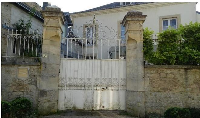
*Mur bahut en pierre de taille, surmonté d'une grille en ferronnerie. Elle est composée d'un barreaudage 21, rue du G<sup>al</sup> - Leclerc à Chenay*
