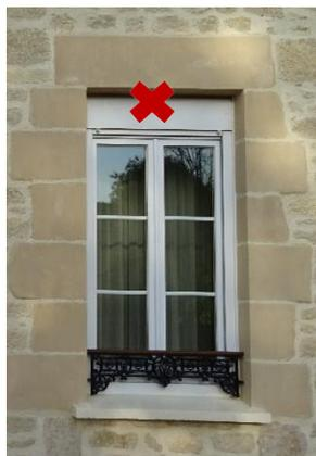
*Exemples de volets roulants en PVC interdits avec coffre saillant ou intégré*
