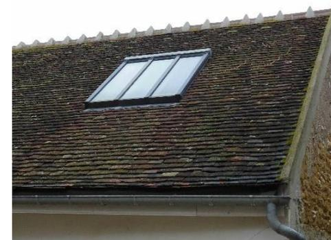
Exemple de verrière métallique avec meneaux verticaux
