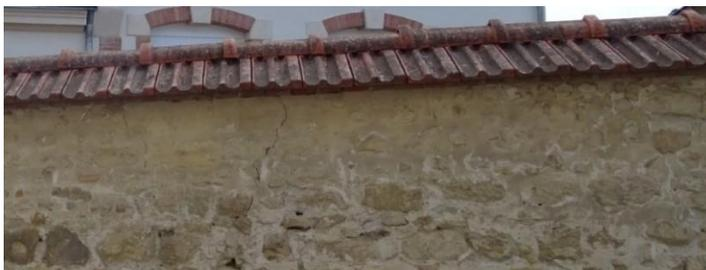
*(4) Un chaperon en tuiles mécaniques dont le faitage est recouvert d'une tuile faîtière à bourrelet de recouvrement*
