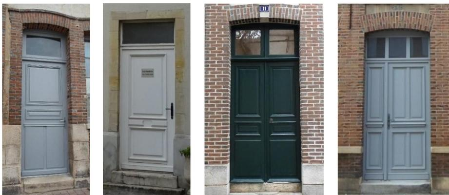
(2) Exemples de portes à panneaux moulurés et assemblés avec imposte vitrée
