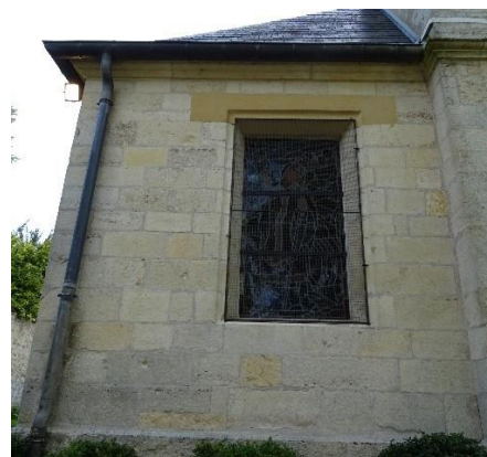
Type 3 : Les façades en parement de pierre de taille -Exemple l'église de Chenay
