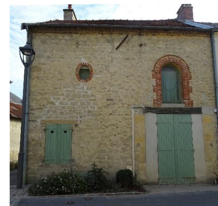
Type 4 : Les façades mixtes, reconstruites après la Première Guerre mondiale – 37, rue du G al Leclerc à Chenay
