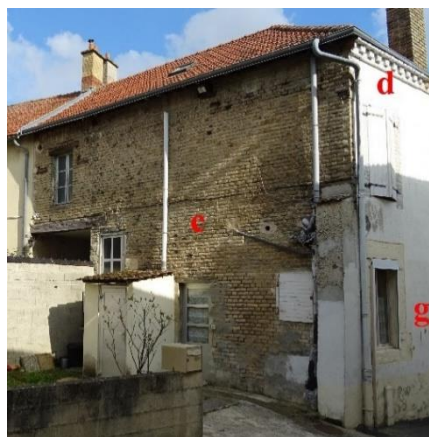
Immeuble 56, rue du G al Leclerc à Chenay : encadrements de fenêtre (a) et de porte charretière (b), en brique peinte (probablement silico-calcaire) ; Corniche à crémaillères en brique (d) et corniche en pierre de taille sur l'immeuble voisin (e) ; Pan coupé probablement créée lors de la reconstruction (f) ; Fenêtre avec un encadrement en pierre de taille calcaire (g) ; façade arrière en maçonnerie de brique silico-calcaire jaune (c)
