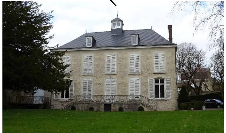
Façade sur le parc
