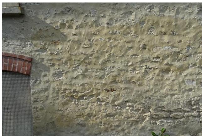
Enduit à pierre vue, 3 rue du Cimetière à Chenay
