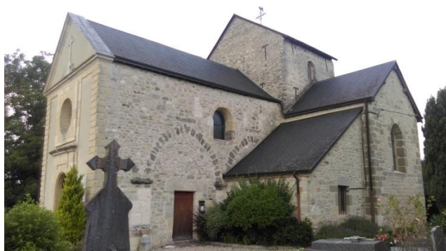
Eglise, vue d'ensemble (2017)
