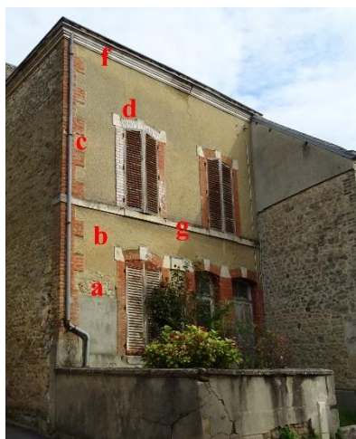
Façade 40, rue du G al Leclerc à Chenay : Maçonnerie de moellons (a), recouverte d'un enduit balayé (b) ; Chainage harpé en brique rouge (c), encadrements de fenêtres et de porte avec des linteaux segmentaires en brique rouge (d) et une clé de voute en pierre (e) ; Corniche en pierre de taille moulurée (f), bandeau en pierre de taille (g).
