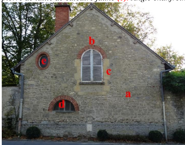
Immeuble 50, rue du G al Leclerc à Chenay : Façade principale en maçonnerie de moellons de pierre rejointoyée (a) encadrements de porte et de fenêtres avec linteaux cintrés, en brique silico-calcaire (b) et corniche en brique en crémaillère (c) ; Pignon en maçonnerie avec un enduit balayé (d) et des encadrements de fenêtre en pierre de taille de calcaire jaune (e). Angle chanfreiné en pierre de taille de calcaire jaune (f).
