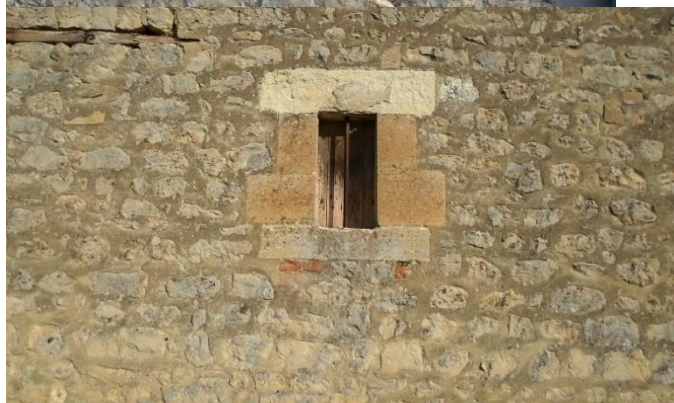
Joint « à cru » rue des Plicheux à Chenay
