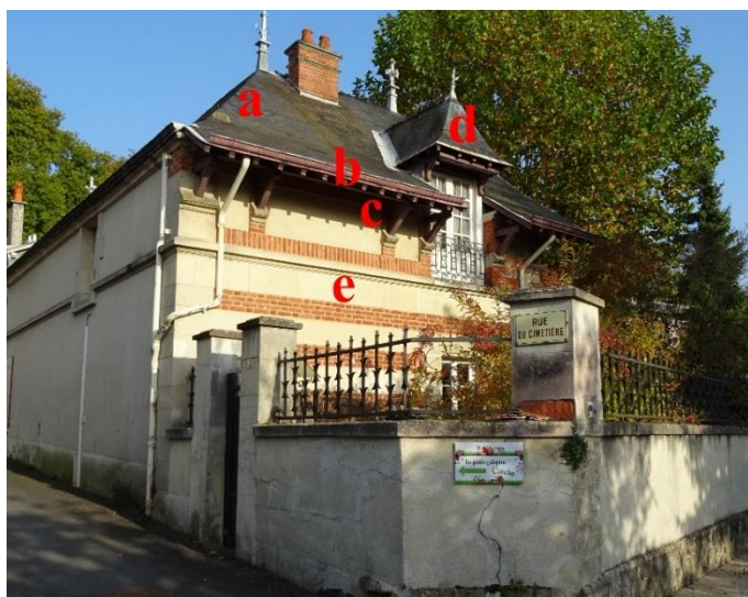
Immeuble 14, rue du G al Leclerc à Chenay : Construction couverte par une toiture à croupe (a), avec un débord de toit (b) soutenue par des aisseliers en bois (c) ; Lucarne pendante à croupe (d) ; Parement composé d'un appareil de brique rouge et de pierre de taille (e) et (g) ; Encadrements de baie harpés en brique et pierre de taille (f) ; Soubassement en pierre meulière (h) ; Enduit balayé (i).
