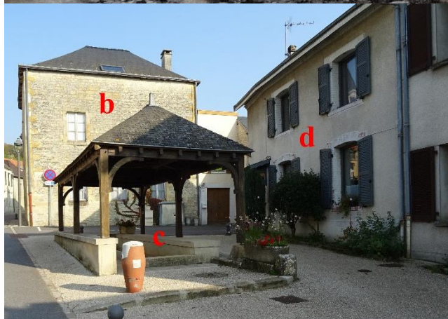
Place de la Source Ferrugineuse - Carte postale © Mairie de Chenay et photo actuelle – Façade et toiture endommagées (b) - Fontaine Ferrugineuse (c) - Façade de maison éventrée au 5, Place de la Source Ferrugineuse (d), reconstruite avec des encadrements de baie en brique aujourd'hui peints
