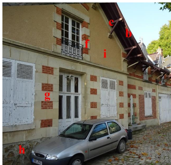
Immeuble 14, rue du G al Leclerc à Chenay : Construction couverte par une toiture à croupe (a), avec un débord de toit (b) soutenue par des aisseliers en bois (c) ; Lucarne pendante à croupe (d) ; Parement composé d'un appareil de brique rouge et de pierre de taille (e) et (g) ; Encadrements de baie harpés en brique et pierre de taille (f) ; Soubassement en pierre meulière (h) ; Enduit balayé (i).
