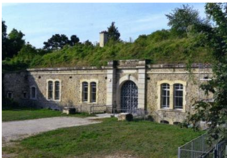
Façade principale – site de la commune de Chenay-
