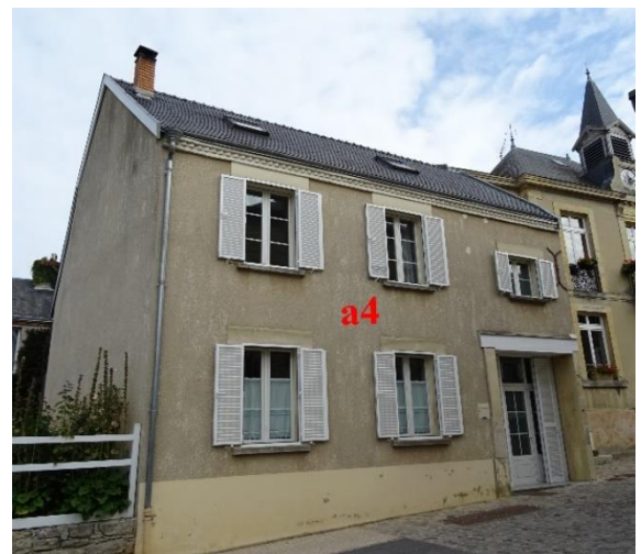
Façade reconstruite du 44, rue du G al Leclerc (a1) - Carte postale © Delcampe vers 1960 – Reconstruction de la façade avec des encadrements en brique (a2) et une corniche en brique à crémaillère (a3) - Réalisation récente d'un enduit ciment gommant les encadrements (a4)
