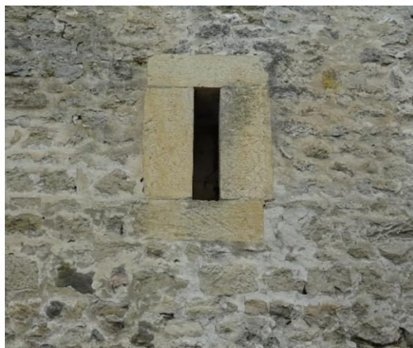
Bâtiment en maçonnerie de moellons de pierre calcaire – Chainage d’angle chanfreiné et encadrement de meurtrière en pierre de taille de calcaire doré - 2, Place Henri IV à Châlons-sur-Vesle
