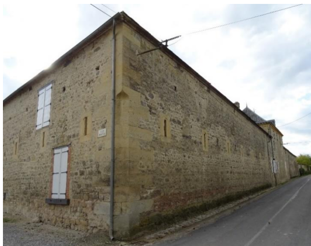
Bâtiment en maçonnerie de moellons de pierre calcaire – Chainage d’angle chanfreiné et encadrement de meurtrière en pierre de taille de calcaire doré - 2, Place Henri IV à Châlons-sur-Vesle
