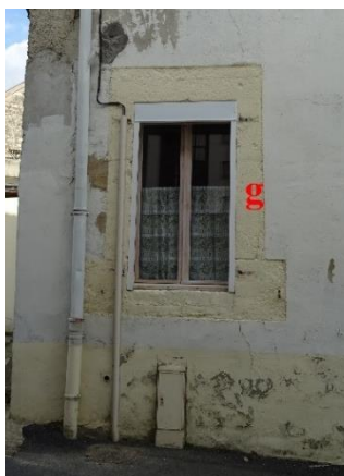
Immeuble 56, rue du G al Leclerc à Chenay : encadrements de fenêtre (a) et de porte charretière (b), en brique peinte (probablement silico-calcaire) ; Corniche à crémaillères en brique (d) et corniche en pierre de taille sur l'immeuble voisin (e) ; Pan coupé probablement créée lors de la reconstruction (f) ; Fenêtre avec un encadrement en pierre de taille calcaire (g) ; façade arrière en maçonnerie de brique silico-calcaire jaune (c)
