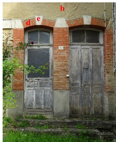
Façade 40, rue du G al Leclerc à Chenay : Maçonnerie de moellons (a), recouverte d'un enduit balayé (b) ; Chainage harpé en brique rouge (c), encadrements de fenêtres et de porte avec des linteaux segmentaires en brique rouge (d) et une clé de voute en pierre (e) ; Corniche en pierre de taille moulurée (f), bandeau en pierre de taille (g).
