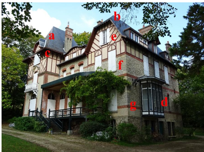
Immeuble 14, rue du G al Leclerc à Chenay : Construction couverte par une toiture à croupe (a), avec un débord de toit (b) soutenue par des aisseliers en bois (c) ; Lucarne pendante à croupe (d) ; Parement composé d'un appareil de brique rouge et de pierre de taille (e) et (g) ; Encadrements de baie harpés en brique et pierre de taille (f) ; Soubassement en pierre meulière (h) ; Enduit balayé (i).
