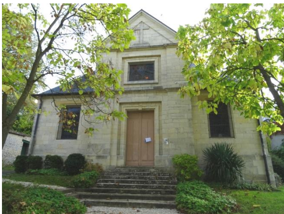
Façade occidentale de l'église (2017)
