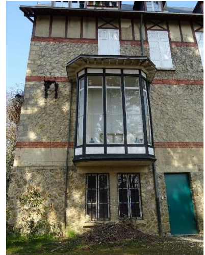
Bow-Window sur le pignon
