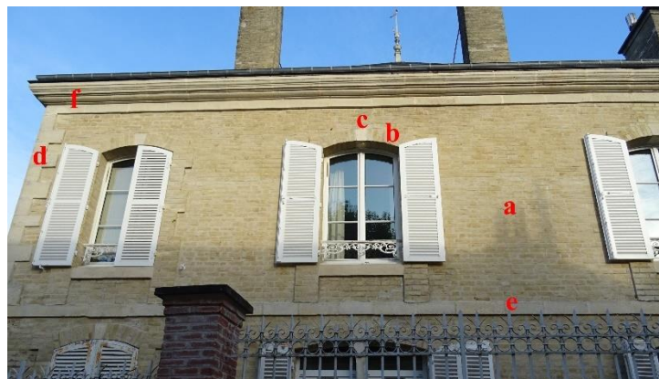
Maison bourgeoise 1, rue du Cimetière à Chenay : Construction avec une toiture à 4 pans - Maçonnerie de brique silico-calcaire (a), encadrements de baies et linteaux segmentaires en brique silico-calcaire (b) et une clé de voute en pierre (c) ; Chainage harpé en pierre de taille de calcaire (d) ; Bandeau en pierre de taille (e) ;
