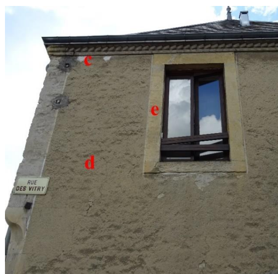
Immeuble 50, rue du G al Leclerc à Chenay : Façade principale en maçonnerie de moellons de pierre rejointoyée (a) encadrements de porte et de fenêtres avec linteaux cintrés, en brique silico-calcaire (b) et corniche en brique en crémaillère (c) ; Pignon en maçonnerie avec un enduit balayé (d) et des encadrements de fenêtre en pierre de taille de calcaire jaune (e). Angle chanfreiné en pierre de taille de calcaire jaune (f).
