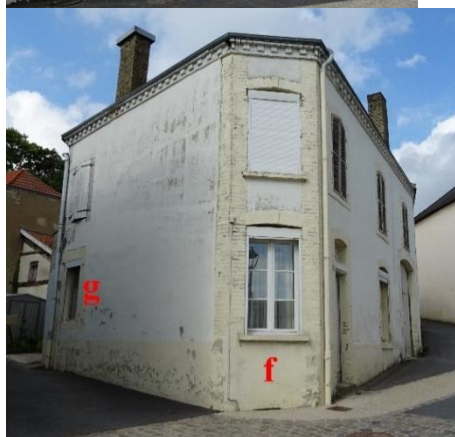
Immeuble 56, rue du G al Leclerc à Chenay : encadrements de fenêtre (a) et de porte charretière (b), en brique peinte (probablement silico-calcaire) ; Corniche à crémaillères en brique (d) et corniche en pierre de taille sur l'immeuble voisin (e) ; Pan coupé probablement créée lors de la reconstruction (f) ; Fenêtre avec un encadrement en pierre de taille calcaire (g) ; façade arrière en maçonnerie de brique silico-calcaire jaune (c)
