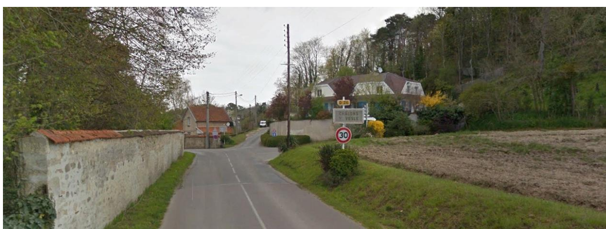
Cône de vue n°2b : Perspective sur l'entrée du bourg, de la route du Moulin compensé. Les murs de clôtures en pierre et les talus participent à la qualité paysagère de cette entrée du bourg.
