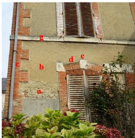
Façade 40, rue du G al Leclerc à Chenay : Maçonnerie de moellons (a), recouverte d'un enduit balayé (b) ; Chainage harpé en brique rouge (c), encadrements de fenêtres et de porte avec des linteaux segmentaires en brique rouge (d) et une clé de voute en pierre (e) ; Corniche en pierre de taille moulurée (f), bandeau en pierre de taille (g).
