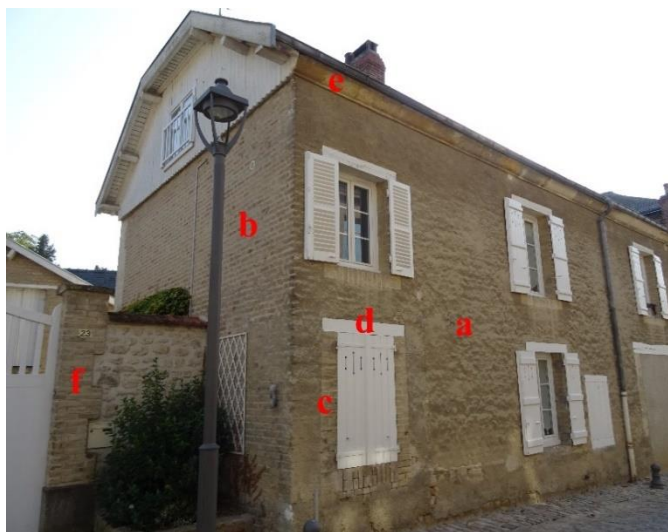
Immeuble 23, rue du G al Leclerc à Chenay : maçonnerie de moellons de pierre avec un enduit balayé (a) ; Pignon en maçonnerie de brique silico-calcaire (b) ; Encadrements de fenêtres en brique silico-calcaire (c) et linteau en bois, (d) ; Corniche en pierre de taille (e) ; Pilier de portail en en brique silico-calcaire (f).
