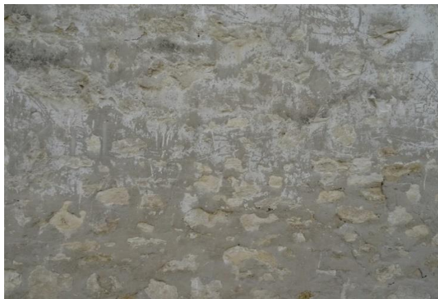
Enduit à pierre vue
