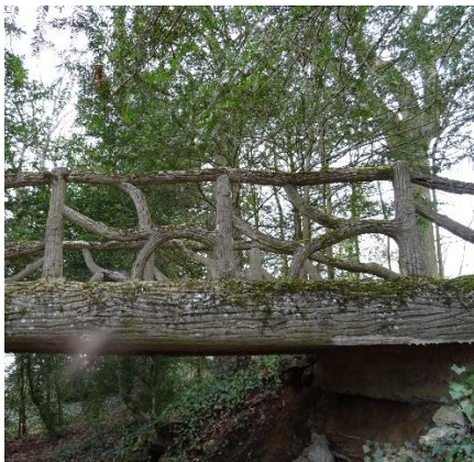
Pont en béton armé, imitant les branches naturelles et portillon d'entrée - Façade arrière
