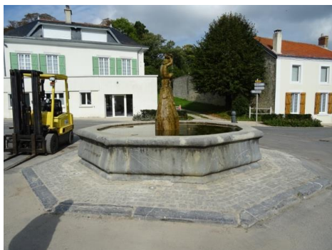
1933 = Travaux de réfection du bassin de la place Boisseau 84 . (2017).
