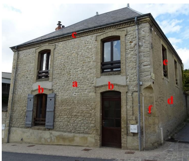
Immeuble 50, rue du G al Leclerc à Chenay : Façade principale en maçonnerie de moellons de pierre rejointoyée (a) encadrements de porte et de fenêtres avec linteaux cintrés, en brique silico-calcaire (b) et corniche en brique en crémaillère (c) ; Pignon en maçonnerie avec un enduit balayé (d) et des encadrements de fenêtre en pierre de taille de calcaire jaune (e). Angle chanfreiné en pierre de taille de calcaire jaune (f).
