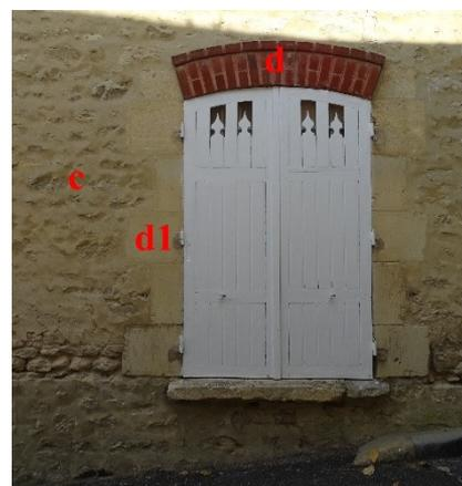
**Immeuble 3, rue du Cimetière à Chenay :** Construction couverte par une toiture à 4 pans avec un débord de toit et des liteaux apparents (a) ; Maçonnerie de moellons de pierre calcaire soit avec appareillage en opus incertum (b), soit recouvert d'un enduit à pierre vue (c) ; Linteaux de baies segmentaires en brique rouge (d) ; Encadrements de fenêtre en pierre de taille calcaire (d1) Bandeaux en brique rouge (e) ; Piliers en pierre de taille calcaire (f), surmontés d'un bandeau en brique (g).
