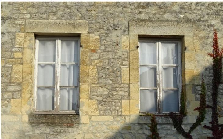
*Bâtiment en maçonnerie de moellons de pierre calcaire avec des percements alignés - Encadrements de baie en pierre de taille de calcaire doré, – 23, rue du Gal Leclerc à Chenay*
