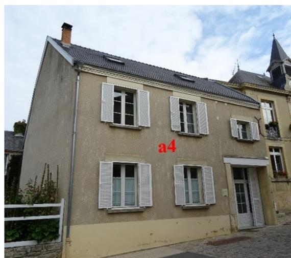
Façade reconstruite du 44, rue du G<sup>al</sup> Leclerc (a1) - Carte postale © Delcampe vers 1960 – Reconstruction de la façade avec des encadrements en brique (a2) et une corniche en brique à crémaillère (a3) - Réalisation récente d'un enduit ciment gommant les encadrements (a4)
