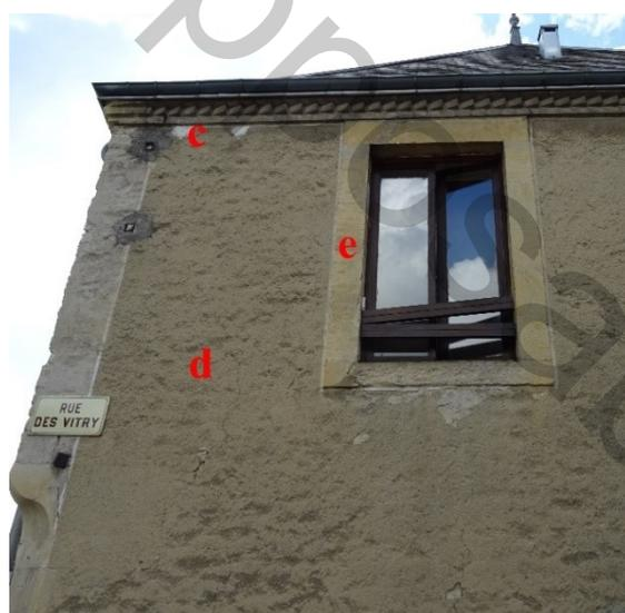
**Immeuble 50, rue du G<sup>l</sup> Leclerc à Chenay** : Façade principale en maçonnerie de moellons de pierre rejointoyée (a) encadrements de porte et de fenêtres avec linteaux cintrés, en brique silico-calcaire (b) et corniche en brique en crémaillère (c) ; Pignon en maçonnerie avec un enduit balayé (d) et des encadrements de fenêtre en pierre de taille de calcaire jaune (e). Angle chanfreiné en pierre de taille de calcaire jaune (f).
