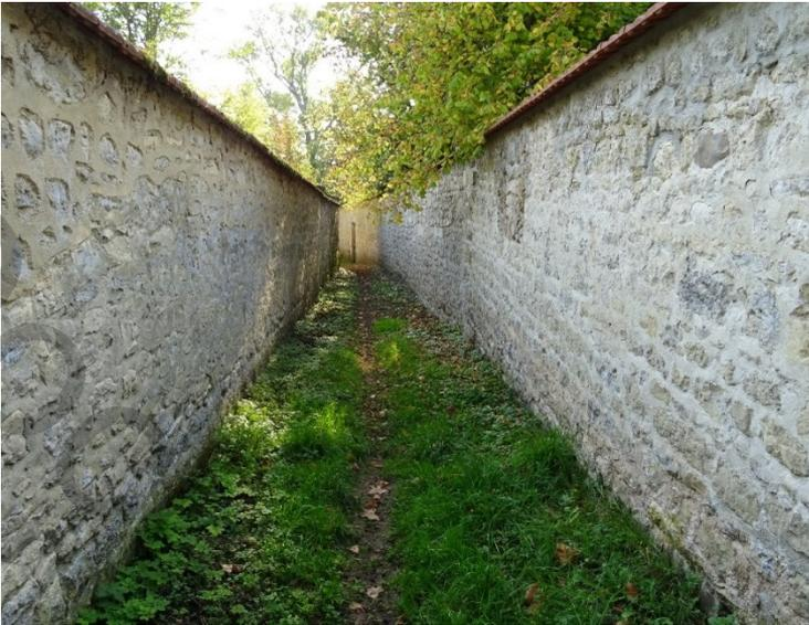
*Mur de clôture en moellons de pierre calcaire, ruelle de la Prache à Chenay les moellons sont posés en assises régulières, assise de moellon large et assise étroite .*
