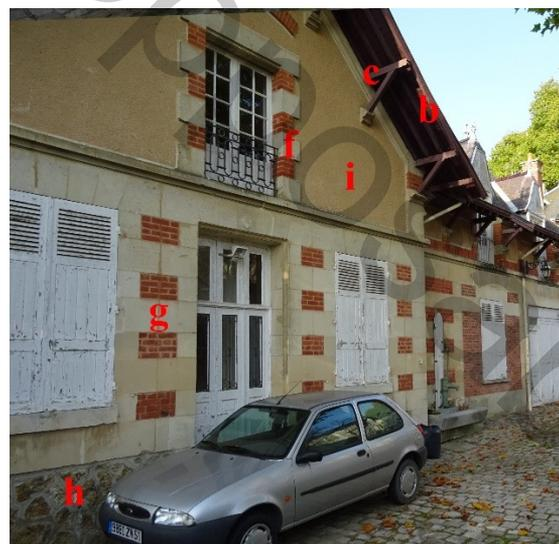
**Immeuble 14, rue du G<sup>al</sup> Leclerc à Chenay :** Construction couverte par une toiture à croupe (a), avec un débord de toit (b) soutenue par des aisseliers en bois (c) ; Lucarne pendante à croupe (d) ; Parement composé d'un appareil de brique rouge et de pierre de taille (e) et (g) ; Encadrements de baie harpés en brique et pierre de taille (f) ; Soubassement en pierre meulière (h) ; Enduit balayé (i).
