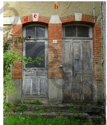
*Façade 40, rue du G<sup>al</sup> Leclerc à Chenay : Maçonnerie de moellons (a), recouverte d'un enduit balayé (b) ; Chainage harpé en brique rouge (c), encadrements de fenêtres et de porte avec des linteaux segmentaires en brique rouge (d) et une clé de voute en pierre (e) ; Corniche en pierre de taille moulurée (f), bandeau en pierre de taille (g).*
