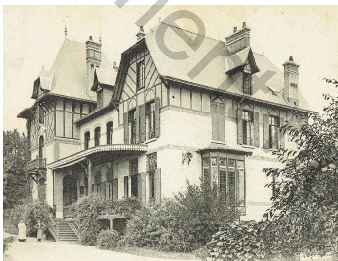
***Villa 4, rue St Nicolas Chenay** : Construction couverte par une toiture à croupe (a), une toiture à demi-croupe (b) avec des débords de toit (c) ; Oriel (d) ; Pan de bois (e) ; Maçonnerie de moellons de pierre en opus-incertum (f) ; Bandeaux de brique rouge (g) ; Portillon en bois (h) dans le mur de clôture en moellon rejointoyé (i).*
