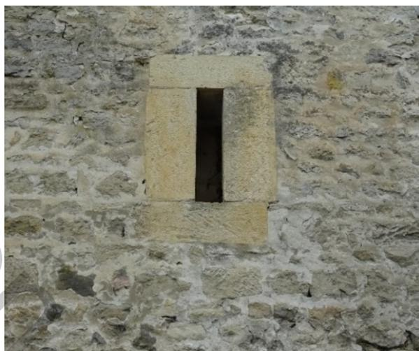
*Bâtiment en maçonnerie de moellons de pierre calcaire – Chainage d'angle chanfreiné et encadrement de meurtrière en pierre de taille de calcaire doré - 2, Place Henri IV à Châlons-sur-Vesle*
