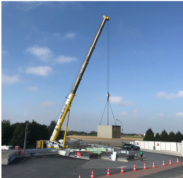
Rénovation de la déchetterie de Witry les Reims
